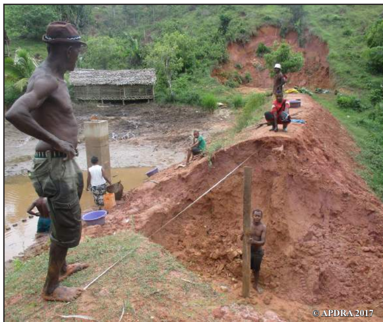
Casse d'une digue d'un pisciculteur à Analanjirofo
